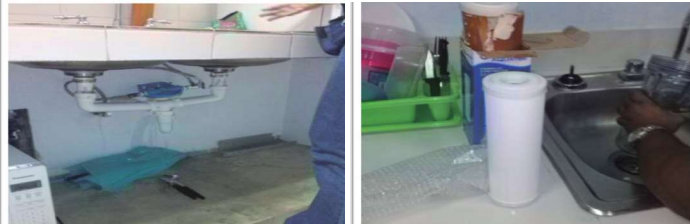
Adecuación y reparación del lavamanos en el comedor.
