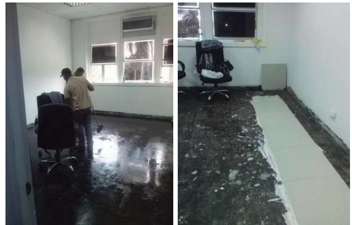
Acondicionamiento de nuevas oficinas.
