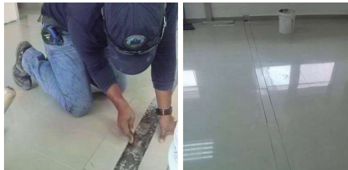
Colocación del baldosas.
