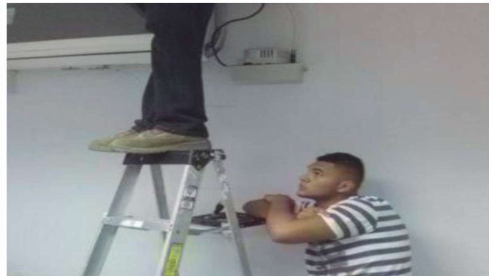
Limpeza de aires acondicionados.
