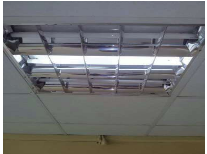
Reparación de lámparas y cambio de focos.
