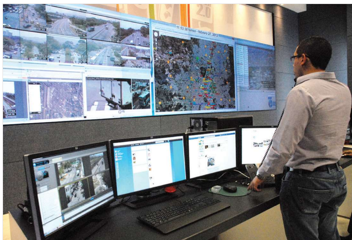
Circuito cerrado de televisión de alta definición
