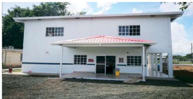
Subestación de Policía de Pesé. Contrato DA-032-2015 Costo BI/. 515,006.43
